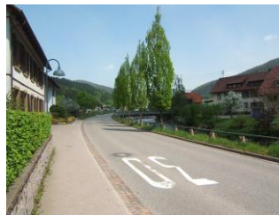
Rys.4. a) zwężenie wlotu na skrzyżowanie z wykorzystaniem zieleni, b) brukowane opaski optycznie zwężające przekrój
