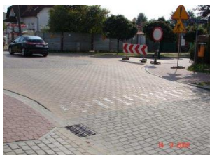
Rys.5. a) zmiany rodzaju nawierzchni w rejonie skrzyżowania wraz ze zmianami wysokościowego ukształtowania obszaru skrzyżowania, b) próg zwalniający typu poduszka na skrzyżowaniu
