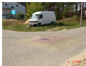
Rys.5. a) zmiany rodzaju nawierzchni w rejonie skrzyżowania wraz ze zmianami wysokościowego ukształtowania obszaru skrzyżowania, b) próg zwalniający typu poduszka na skrzyżowaniu
